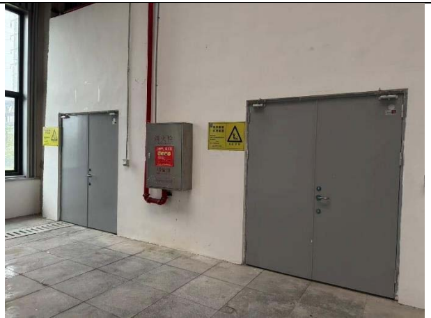
危废暂存间（外）
